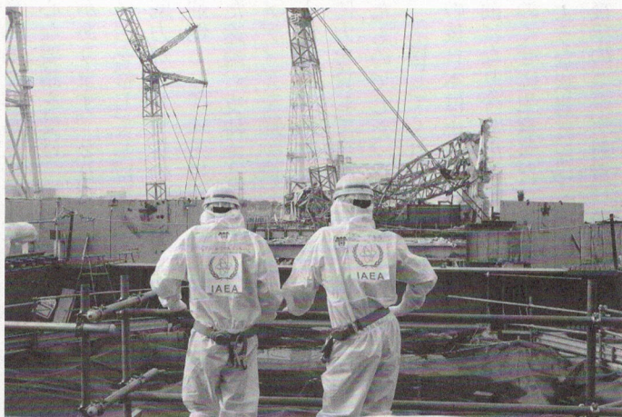
現在も廃炉作業の続く福島第一原発。2月13日の地震は3・11の悪夢を思い起こさせた。しかし、政府の原発推進の姿勢は変わらない。
